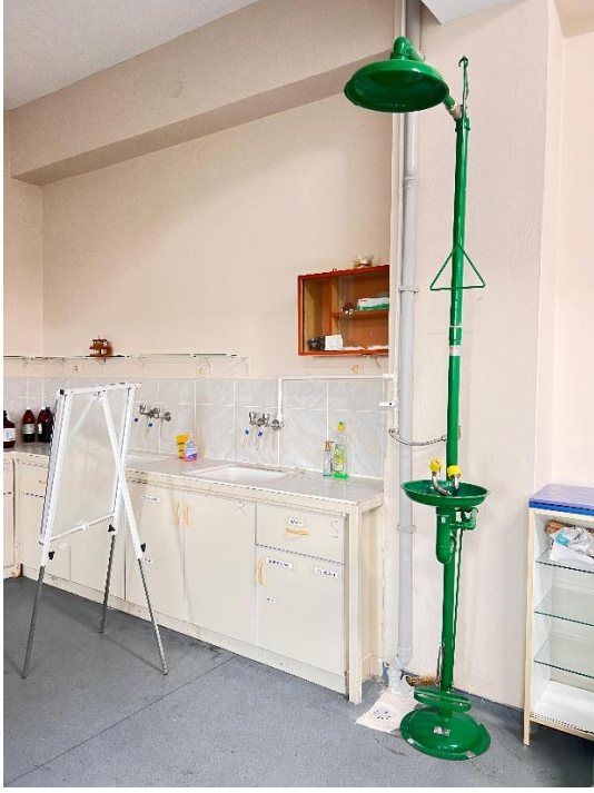
Kimya Laboratuvarı-Acil Vucüt Duşu ve Göz Duşu Ünitesi
